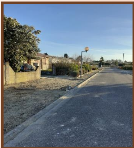
Réfection des trottoirs, lotissement Larigodière
