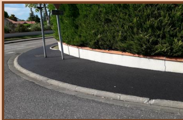
Réfection des trottoirs, lotissement Larigodière
