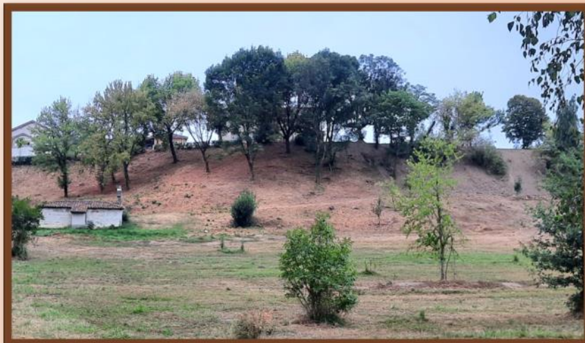
Aménagement du talus
