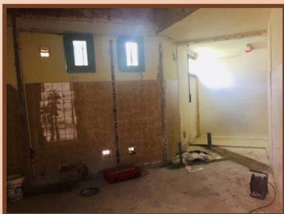
Rénovation des sanitaires salle polyvalente
