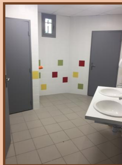
Rénovation des sanitaires salle polyvalente
