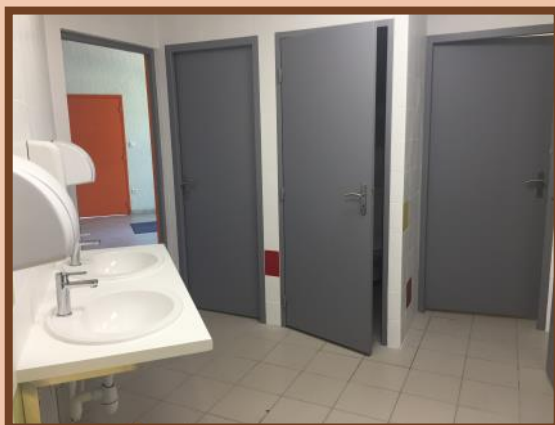
Rénovation des sanitaires salle polyvalente
