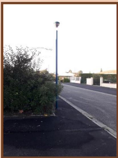
Éclairage lotissement Larigodière
