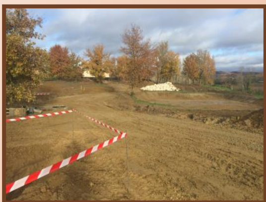
Lotissement « la chapelle »
