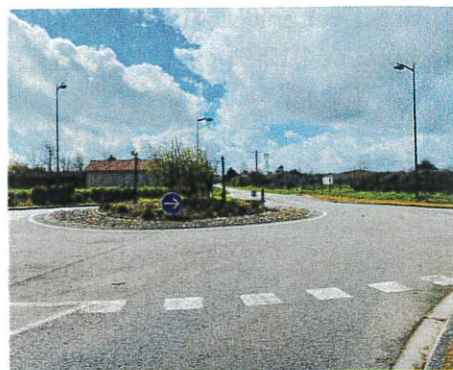
Poursuite du déploiement de l'éclairage public en LED
